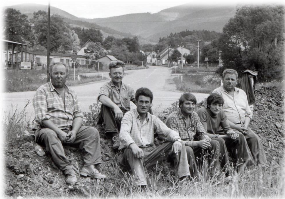
Foto: Výkopové práce na křižovatce v Čisté.
