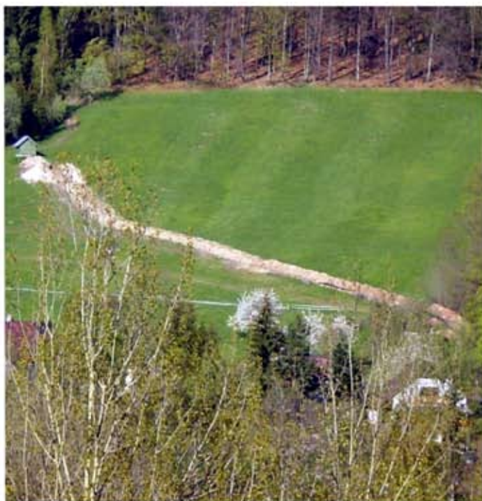
Černý Důl Do zdáli viditelné rýhy od vodojemu nad Miletou směřující šikmo dolů ke hřbitovu bude uloženo vodovodní potrubí pro nově zahajovanou výstavbu na pozemcích u tenisových kurtů.
