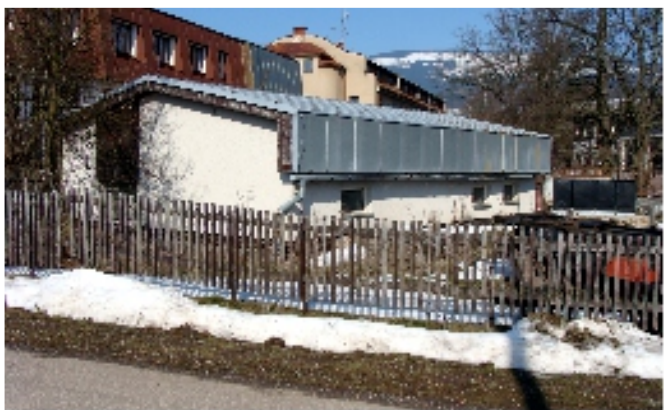
Čistička odpadních vod bývalého zemědělského učiliště na st. p. č. 277 v Čisté v Krkonoších.
