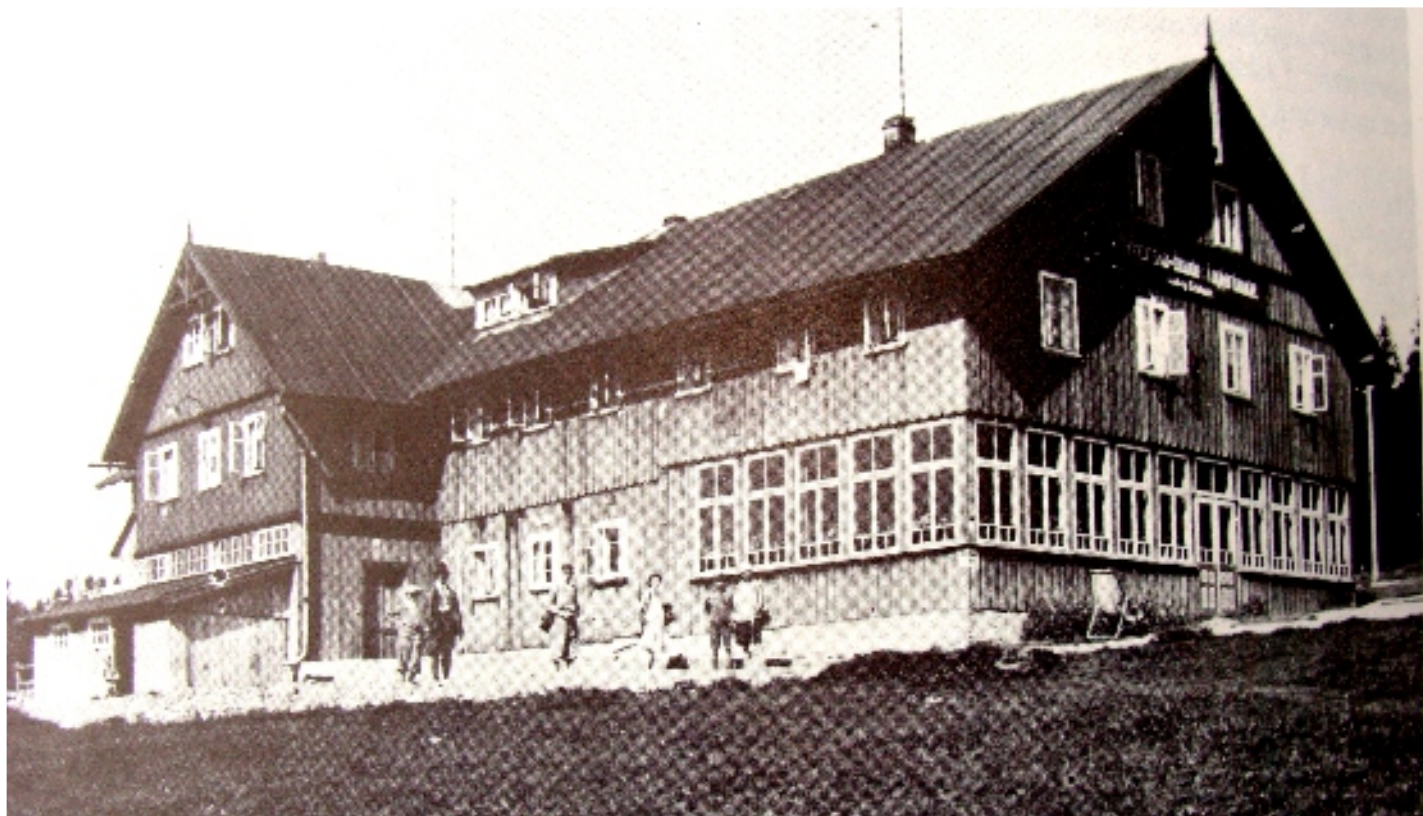
Nová Hrnčířská bouda tak, jak byla obnovena po požáru v r. 1939
