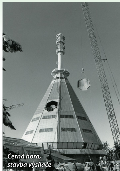
Černá hora, stavba vysílače
